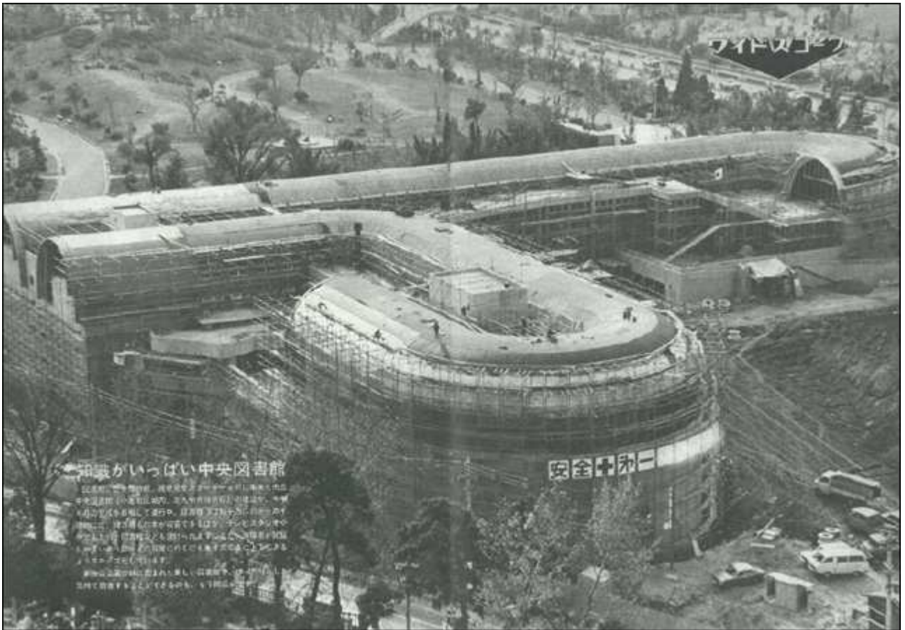
建設中の中央図書館 (1) [52]
