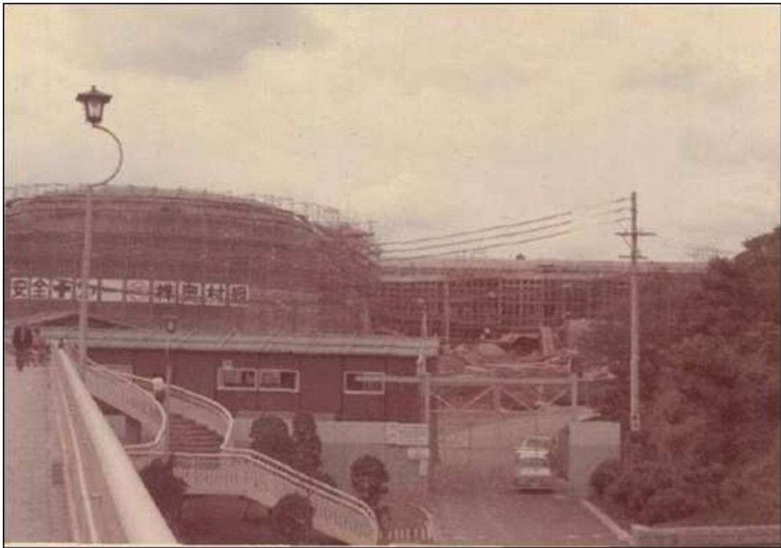
建設中の中央図書館（3） [12]
