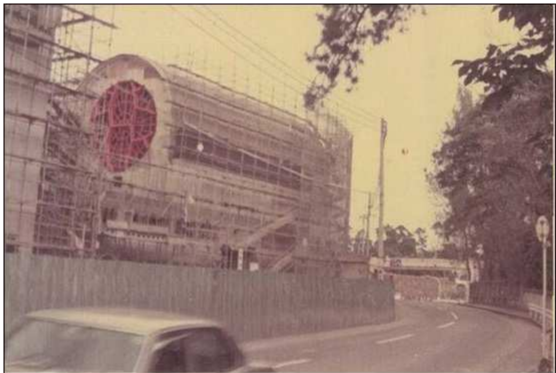
建設中の中央図書館 (2) [12]
