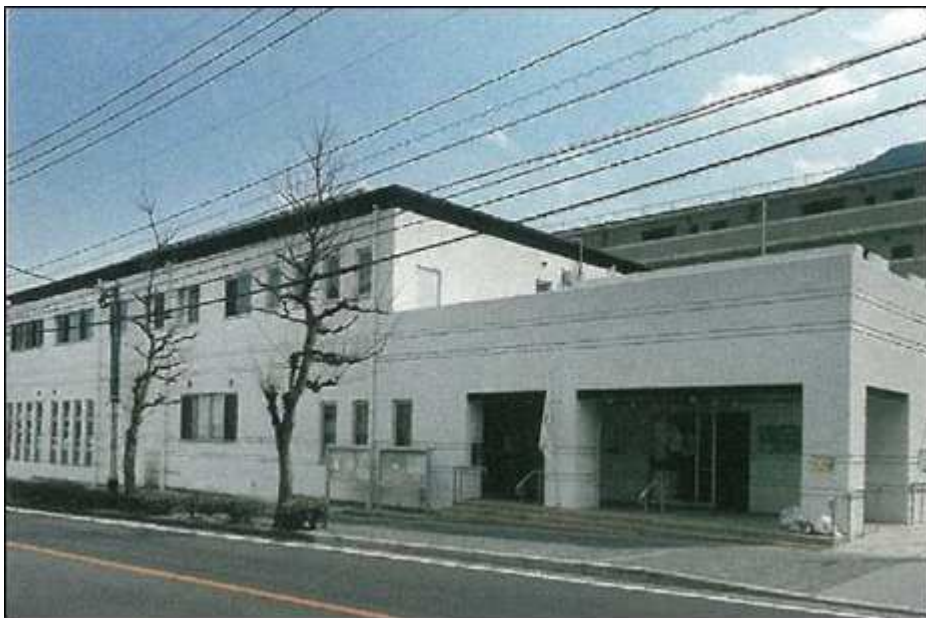
平成 23（2011）年移転開館の大里こどもと母のとしょかん（大里分館） [12] （大里柳市民センター 2 階）
